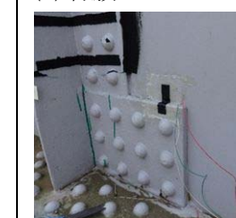
き裂センサーの開発 発:橋梁への貼付実証 実験を実施中
