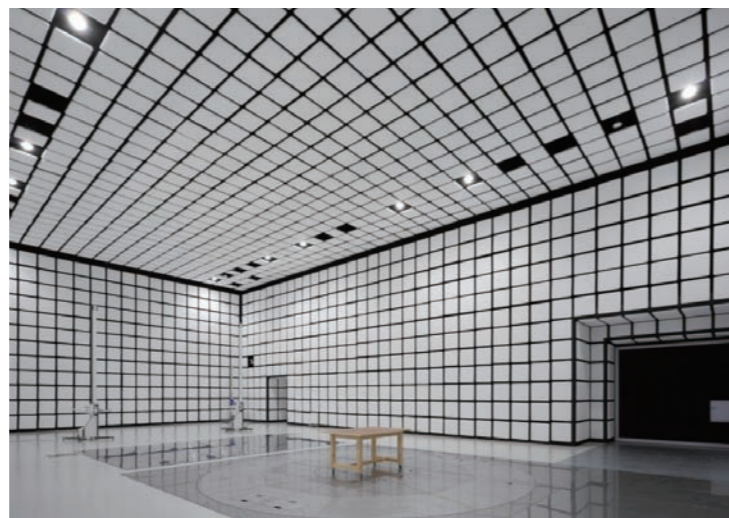
EMCサイト・10m法電波暗室
