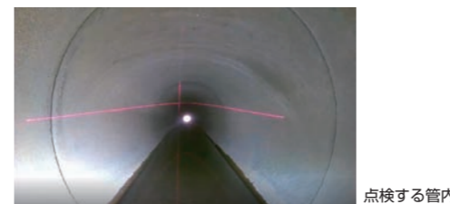
点検する管内
