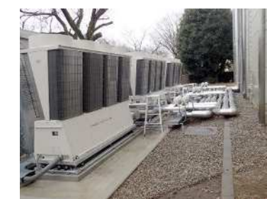
(事例 3) 多摩テクノプラザ B 棟空調設備改修工事
