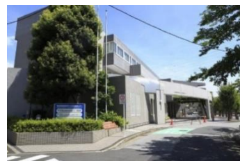
城東センター外観
