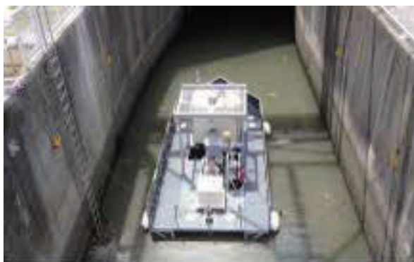
河川に設置した水質改善装置
