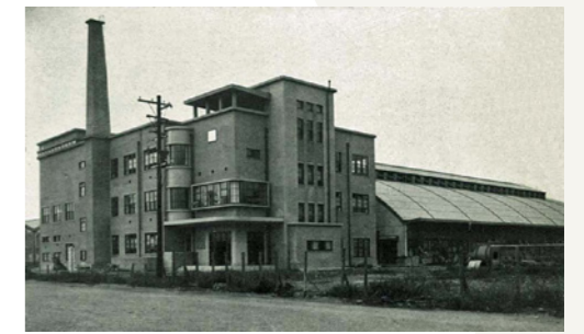
機械部本館と作業場
