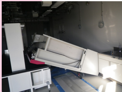
青海の本部の震災被害（ドラフト転倒）
