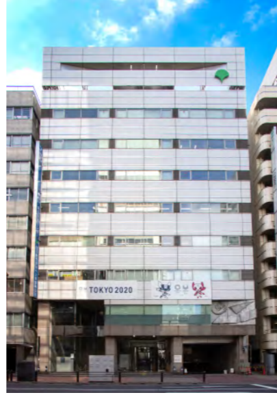
食品技術センター(6・7・8階)の外観
