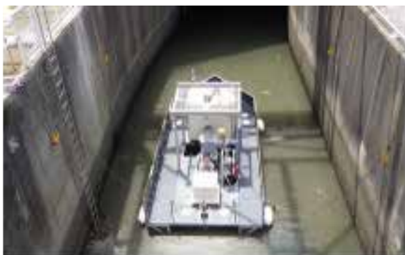
河川に設置した水質改善装置
