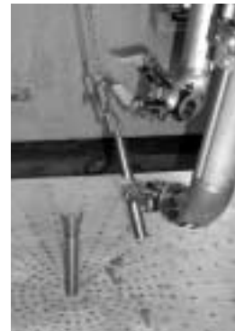
写真3 交換作業の様子 (模擬線源によるリハーサル)
