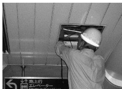
写真2 天井裏点検例
