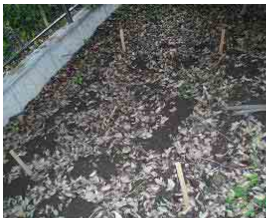
図1 埋設現場の状況
