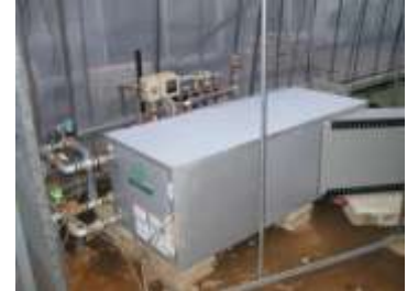
図 1 水熱源型ヒートポンプ 米国 FHP 製・4 馬力
