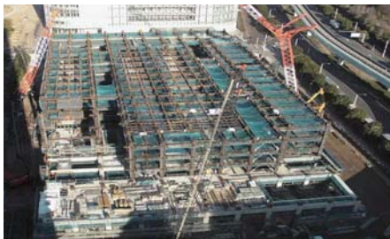
図1 新本部現場建築工事状況 (全景H22.1.14撮影)
