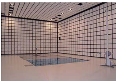
図5 10m法電波暗室の内観
