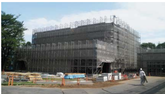
図2 EMCサイト(工事風景 5月12日撮影)
