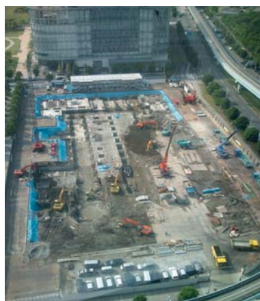
図3 区部拠点建設工事の現場状況 (全景 6月17日撮影)
