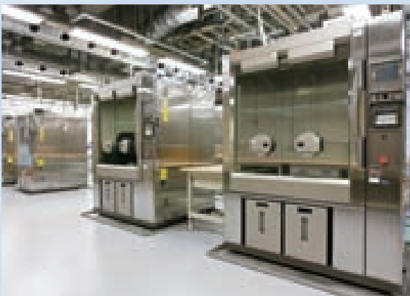
実証試験セクター 恒温恒湿槽群
