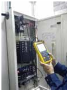
図1 工場での電氣量測定状況
