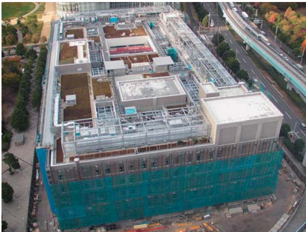
図1 新本部建設現場全景 (H22.11.19撮影)
