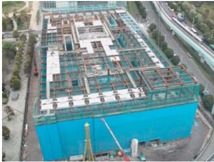
図1 新本部現場建築工事状況 (全景H22.4.14撮影)
