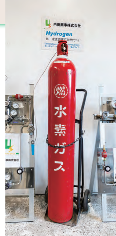
(左)水素ガスボンベ (下)水素コンロでの調理の様子 水素調理では、水素と酸素が結合して水をつくることで燃焼部周辺の湿度を引き上げ、外側はカリカリに、内側はジューシーに焼きあげることができます。水素コンロの使用にあたって、特別な資格などは不要です。
